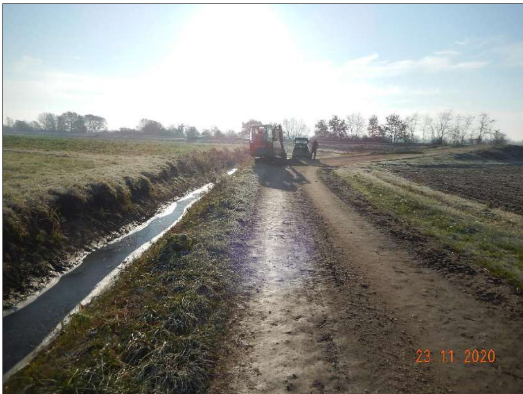
Odsek ureditve dostopne ceste – območje izkopa S-1 in S-2 (Foto: 23. 11. 2020)
