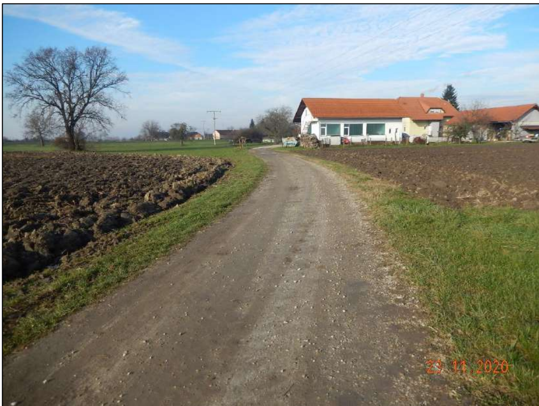
Odsek prenove lokalne ceste – zahodni del (Foto: 23. 07. 2020)
